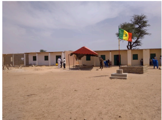
Drei neue Klassenzimmer, eines im Bau, Jan. 2018
